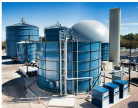
Figura 5: Digestor com aproveitamento da energia nos EUA Harvest Energy Garden de Parque Walt Disney, tratamento de esgotos sanitários e restos de comida.
