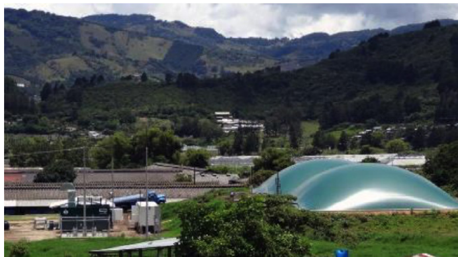
Figura 11: Lagoa para dejetos suínos e resíduos de matadouro.
