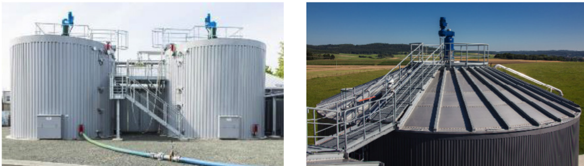
Figura 17: CSTR com misturador central.
