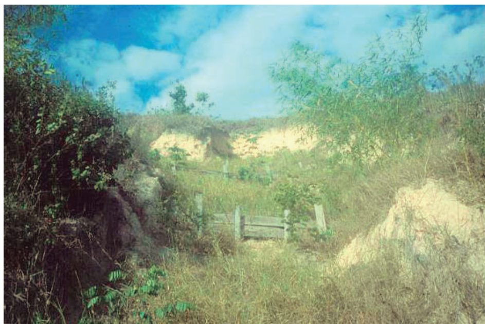
FOTO 17 – Área degradada de voçoroca em processo de recuperação, através do uso de paliçadas e revegetação com espécies de gramíneas, leguminosas e bambus
