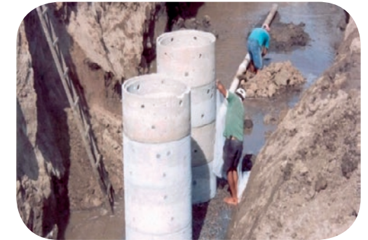
Poço com anéis de concreto
