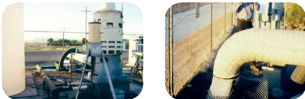
Sistema de Poço de Injeção/Produção do SRP, Arizona, com detalhe da vazão injetada no canal principal
