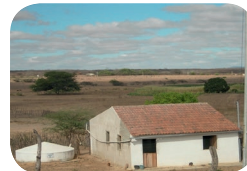
Implúvio aproveitando a calha do telhado com acumulação numa cisterna
