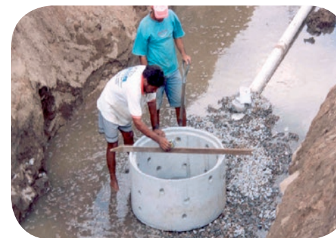
Poço (1º anel) com dreno
