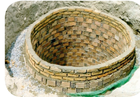
Poço amazonas feito com tijolos
