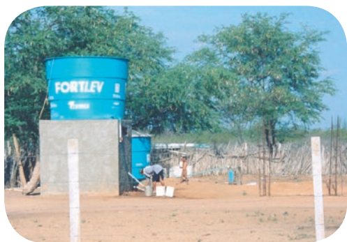
Chafariz/caixa d'água com base em alvenaria
