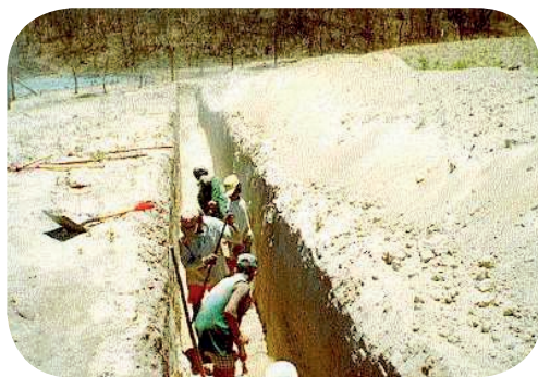
Escavação manual da vala
