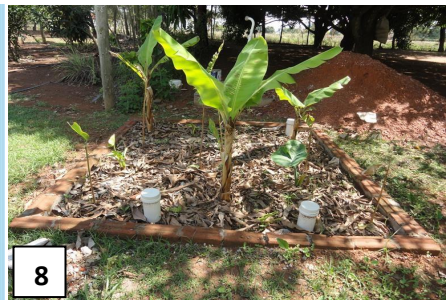
Figura 5: caixa seca, tecnologia social para o aumento da captação de água na propriedade; Figura 6: formação de estudantes da Escola Família Agrícola Puris de Araponga/MG (EFA-Puris) em Educação Ambiental; Figura 7: modelo esquemático de uma fossa evapotranspiradora; Figura 8: fossa evapotranspiradora coletivamente construída por agricultores familiares durante um mutirão de formação.
