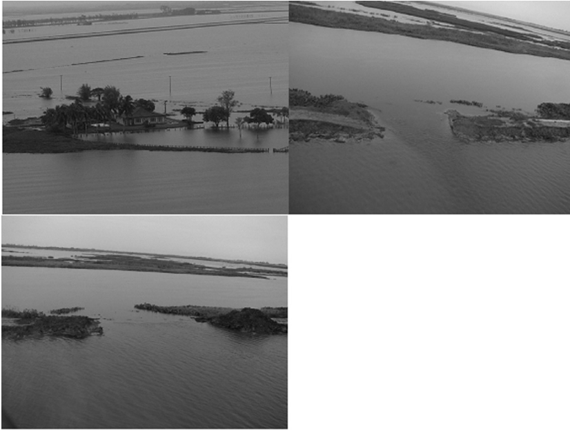
Acima, à esquerda: sede da fazenda da Ilha dos Carães isolada após detonação de dique; à direita: fenda no dique da fazenda do Louro causada por dinamite. Abaixo: fenda no dique da fazenda Capivari causada por dinamite. Fotos: Site Ururau .
