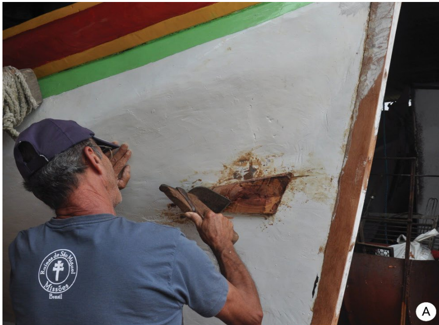
Figura 13 – Remendo em local sem curvatura (A) e enxó (B)
