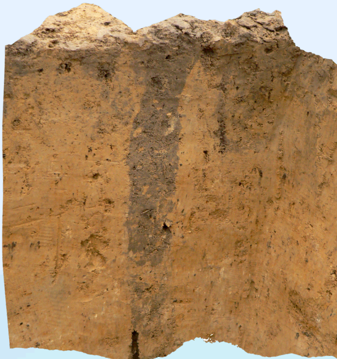
Figura 1: Solo compactado Fonte: commons.wikimedia.org
